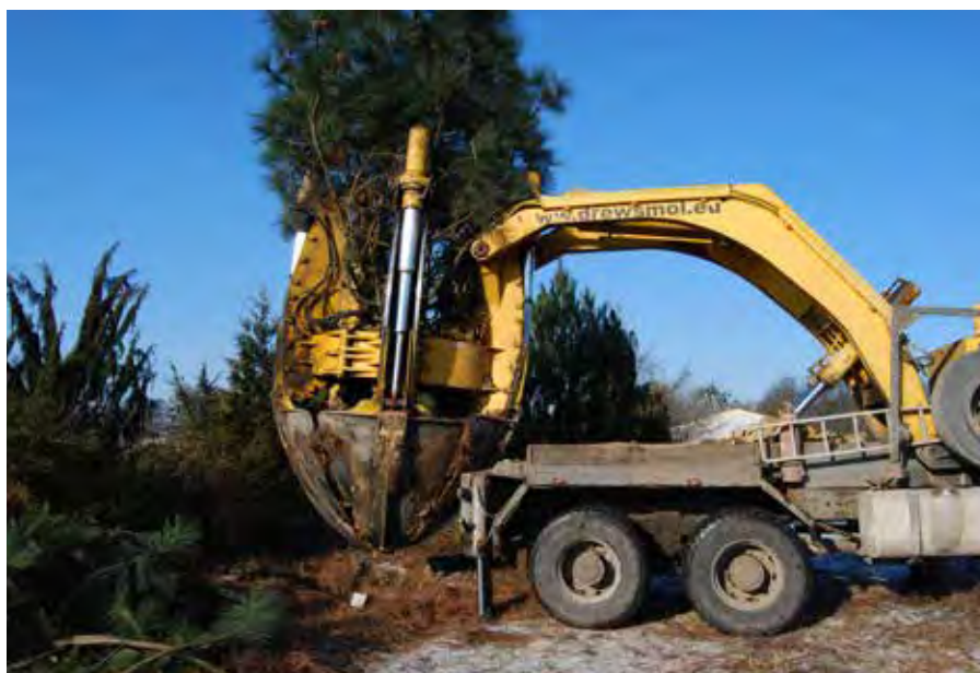
Wykopana i podniesiona roślina
